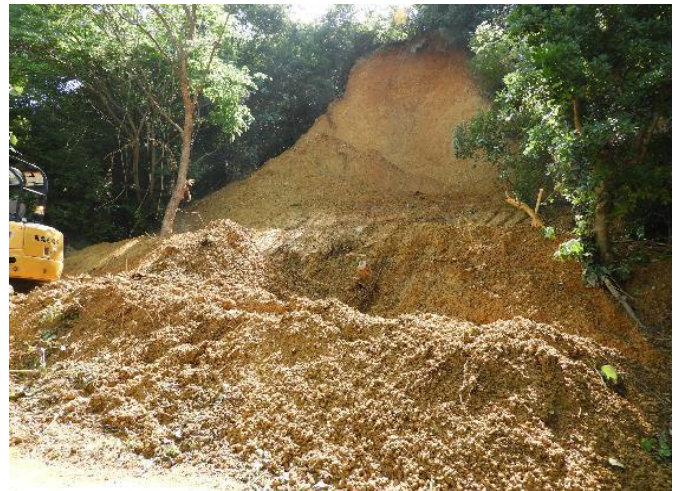
近くから見た現場
