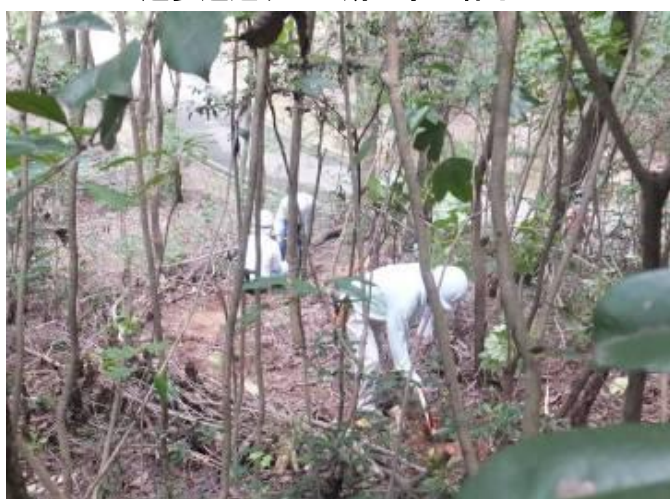
遊歩道造りの三期工事の様子
